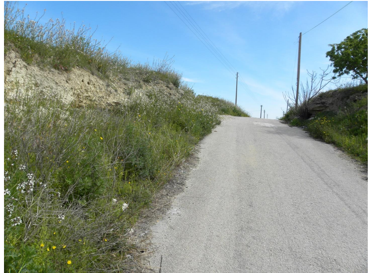
Foto 18 – Via Roosevelt - vista verso ovest (3)
