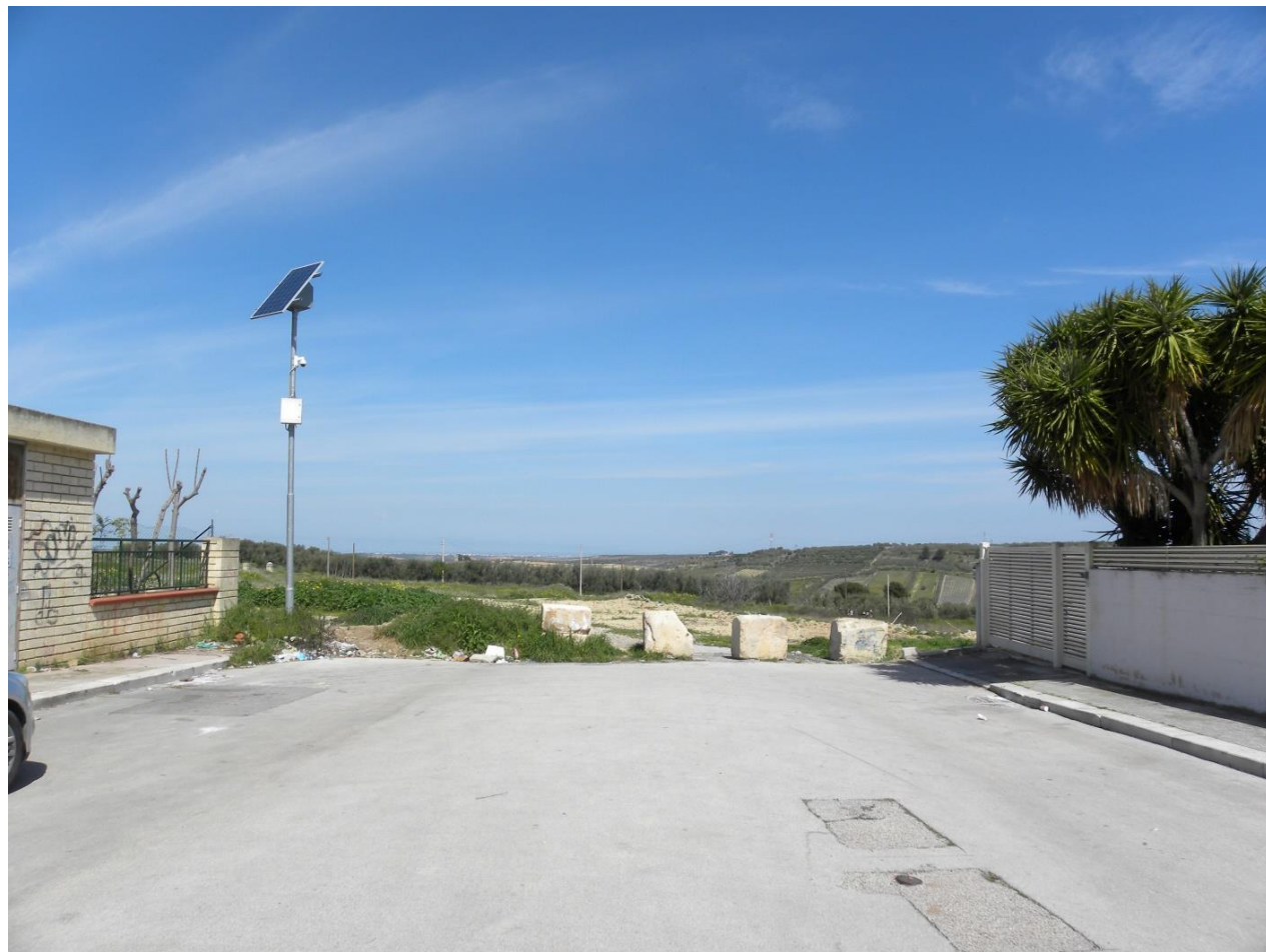
Foto 3 – Accesso dalla confluenza fra Via Capurso e Via Rizzi
