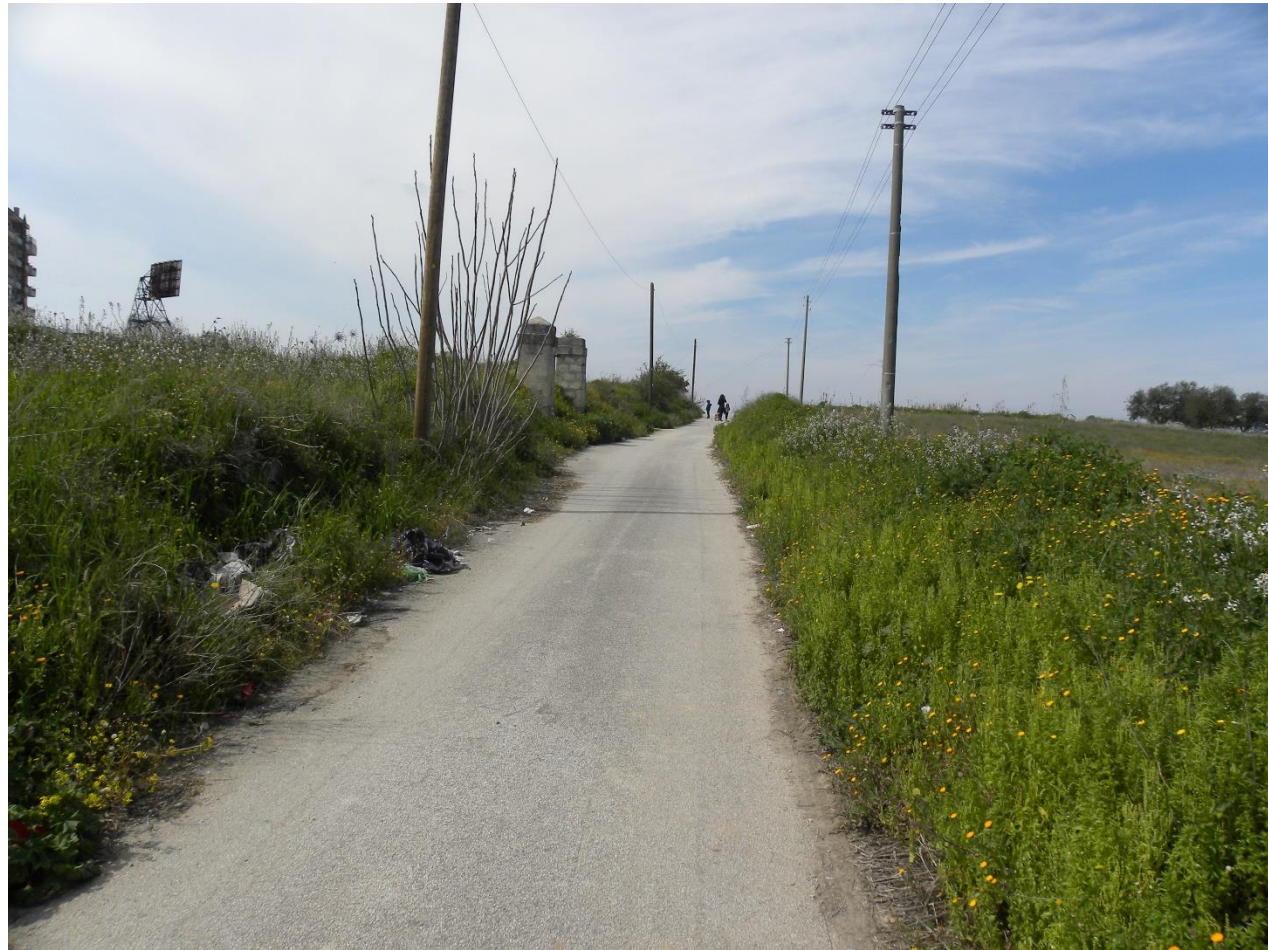
Foto 17 – Via Roosevelt - vista verso ovest (2)
