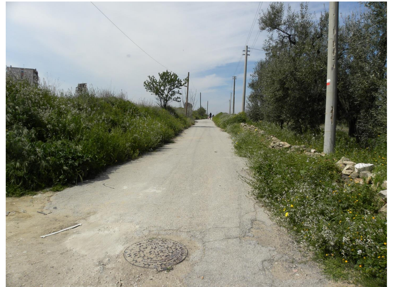
Foto 16 – Via Roosevelt – vista verso ovest
