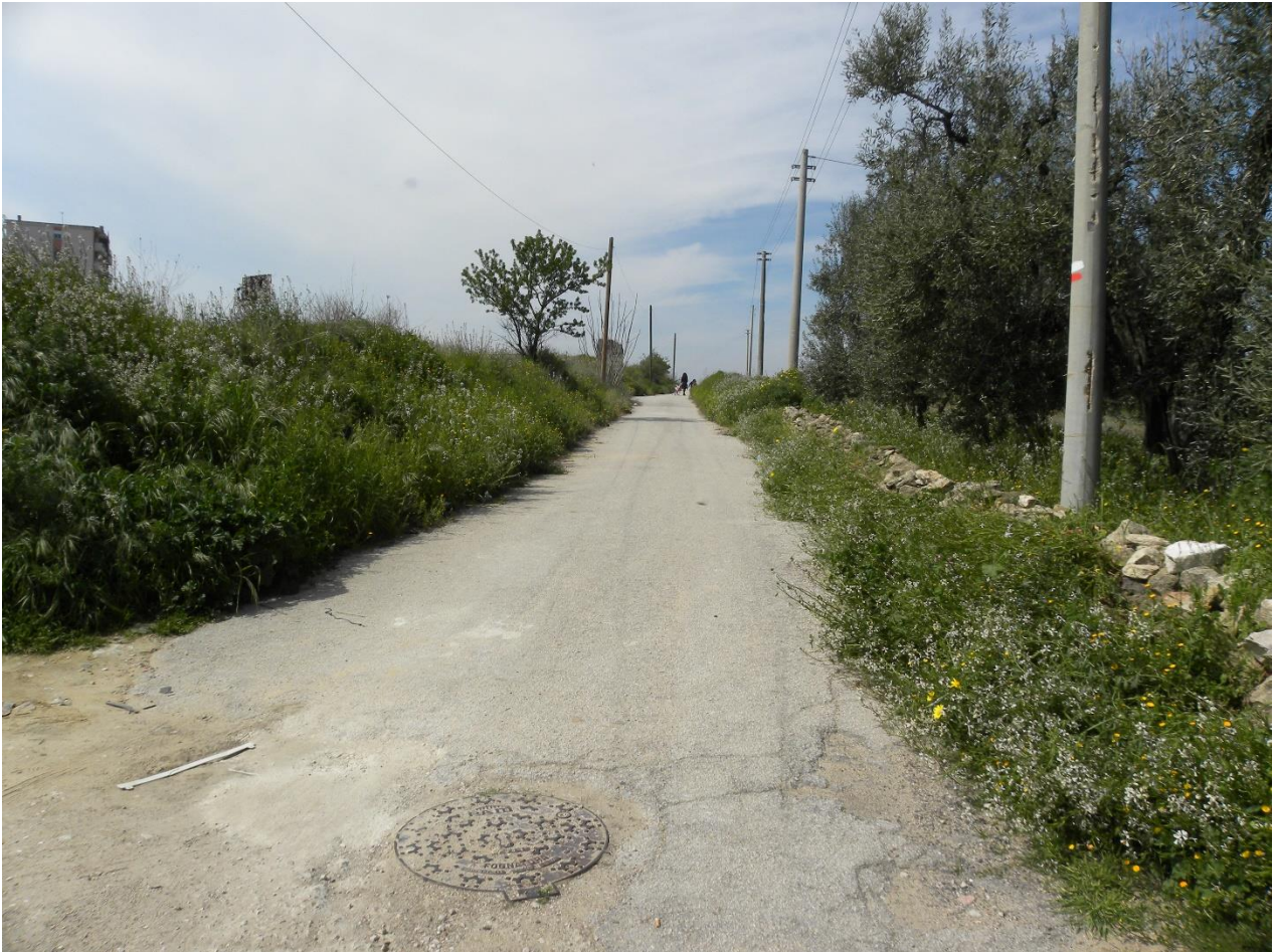
Foto 14 – Via Roosevelt – vista verso ovest
